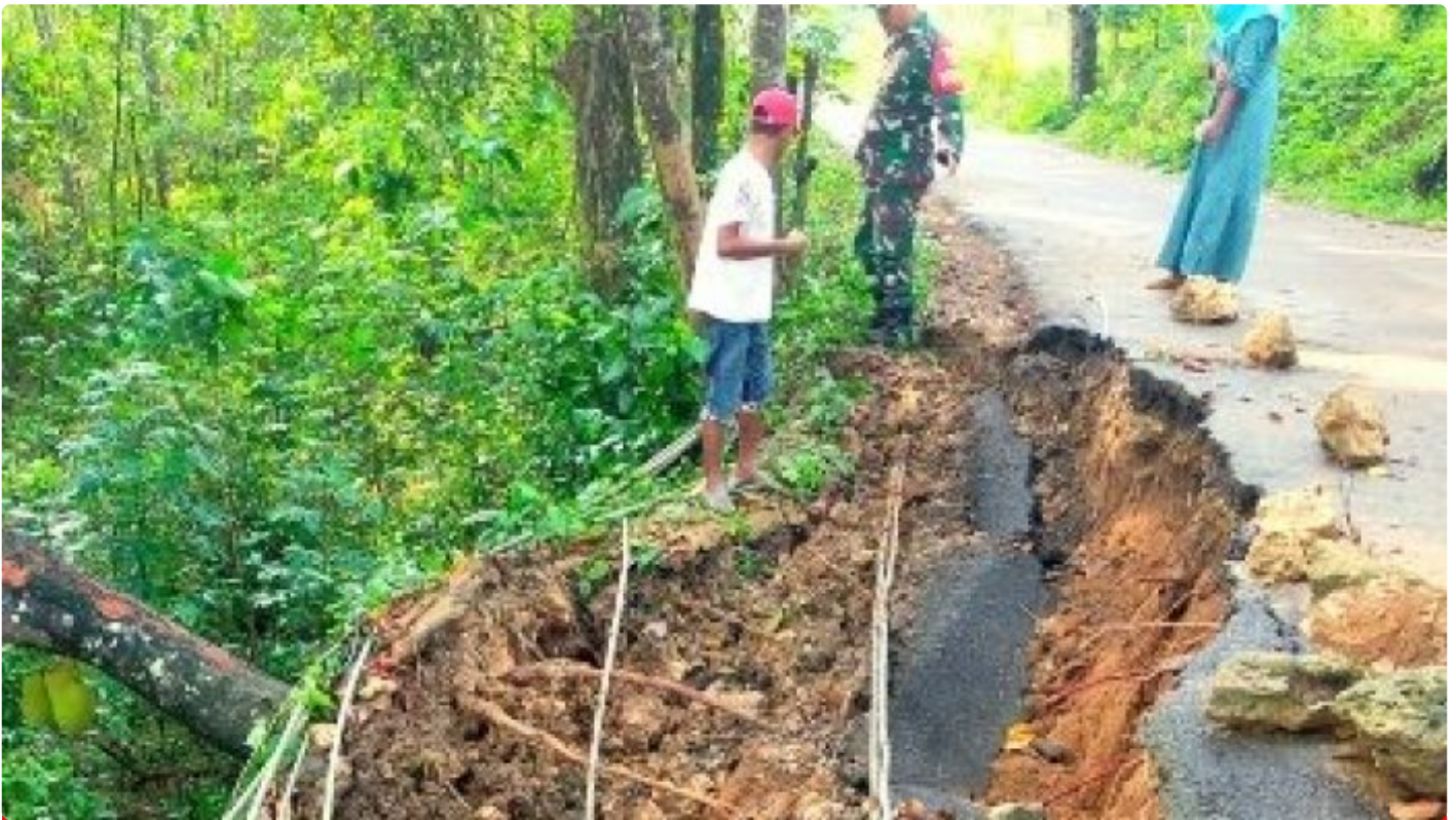
Personel Koramil 0829-10/Galis saat mengecek jalan longsor dampak dari hujan deras pada Senin sore
